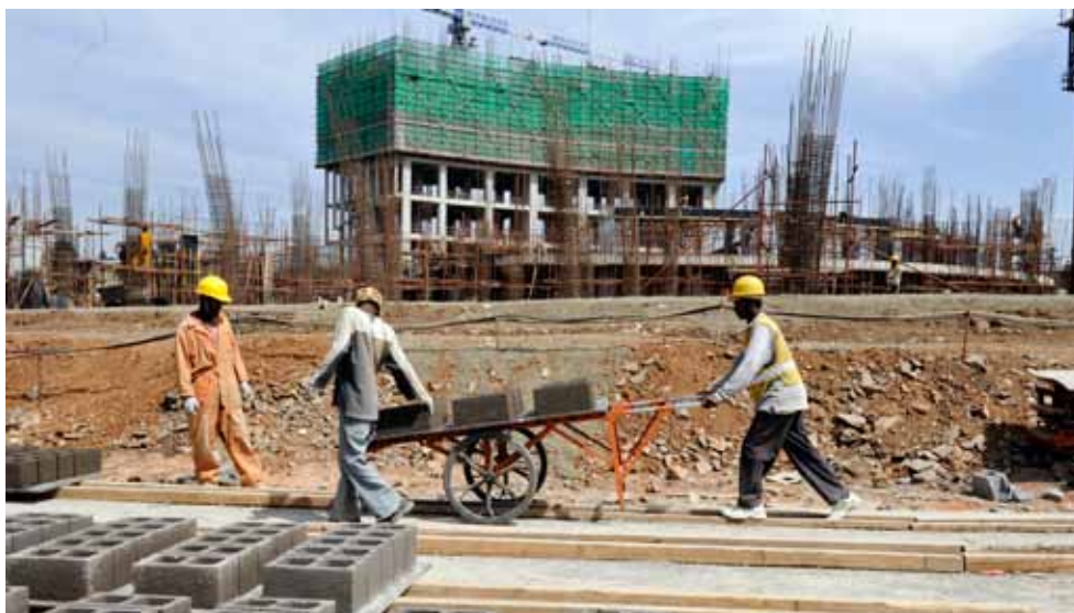
Construction sur le site du nouveau centre de conférence de l'Union Africaine (UA) à Addis Ababa, Éthiopie. Photo : ANP/AFP
